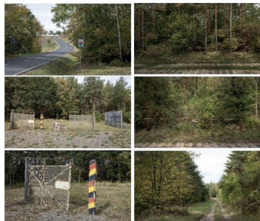
Planches 1 et 2 : Entre Rieth et Zimmerau, Restes de la clôture extérieure et Restes du chemin de garde. Jean-Philippe Astolfi.
